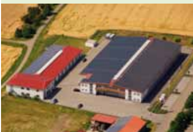
Photovoltaikanlage auf den Firmendächern
